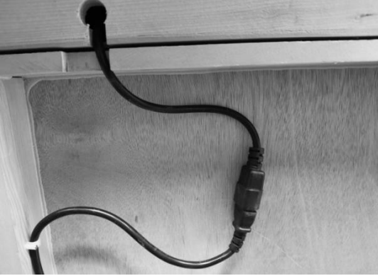
(1) Csatlakoztassa a fűtőelemek kábelét.
