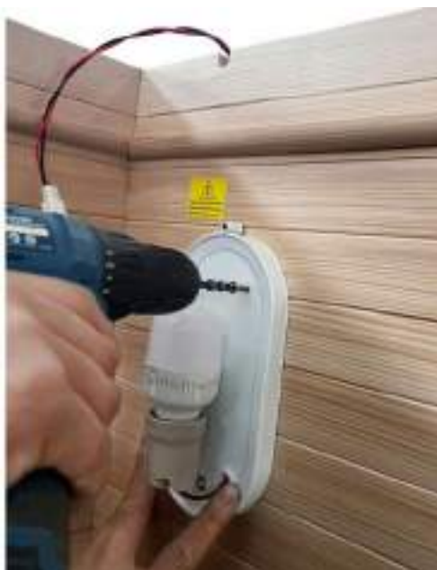
12. Za pričvršćivanje postolja svjetiljke za saunu koristite vijke, pogledajte gore - vijci za staklo M3x20 mm
