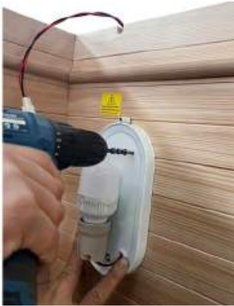
12. Ataşați lumina de saună cu șuruburi, vezi mai sus, șuruburi de sticlă M3x20mm
