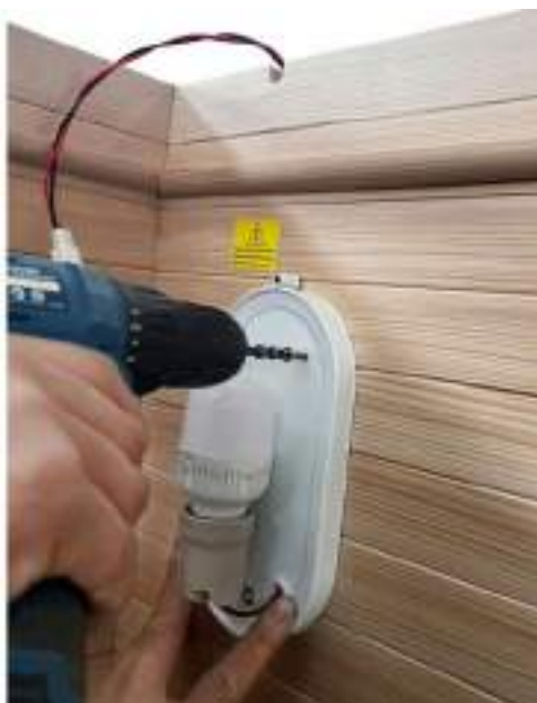
12. Za pritrditev podstavka svetilke za savno uporabite vijake, glejte zgoraj - vijaki za steklo M3x20 mm
