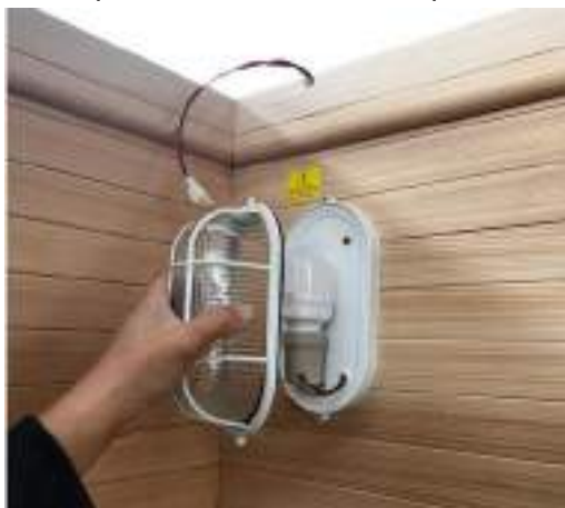
13 Namontujte vodotěsný kryt saunového svítidla, stačí použít šrouby, viz foto výše Skleněné šrouby M3x20mm
