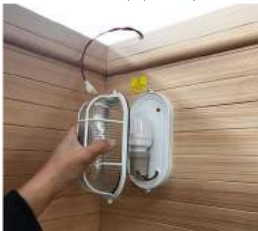
13 Namontujte vodotesný kryt saunového svetla, stačí použiť skrutky, viď fotografia vyššie Sklenené skrutky M3x20mm
