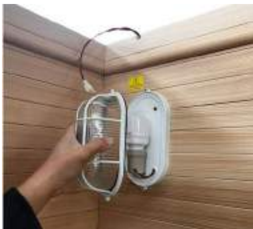
13. Postavite vodootporni poklopac svjetla za saunu samo vijcima, pogledajte gornju sliku - stakleni vijci M3x20 mm
