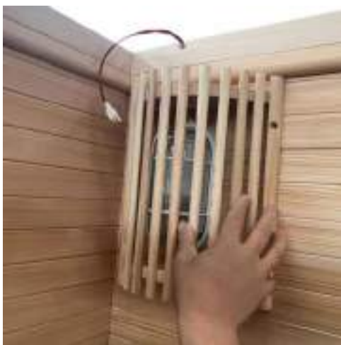
14. Ugradite drveni poklopac svjetla za saunu pomoću vijaka 3,5x25
