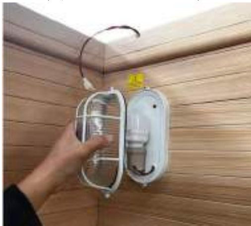
13 Instalați capacul impermeabil al luminii de saună, folosiți doar șuruburi, vezi fotografia de mai sus Șuruburi M3x20mm
