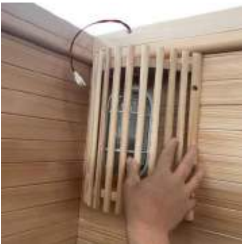
14 Holzabdeckung für Saunaleuchten montieren, Schrauben 3.5x25
