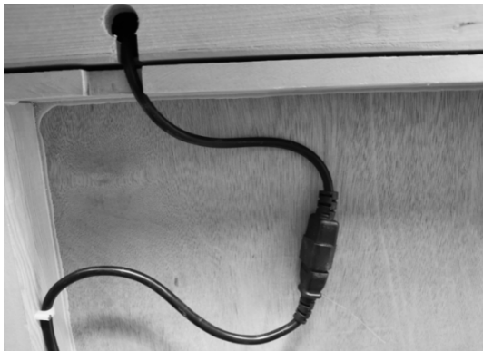
(1) Priključite konektorje grelnih kablov, poskrbite, da kabli niso stisnjeni med stropne plošče in druge plošče.
