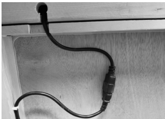
(1) Conectați fișele cablurilor de încălzire. Asigurați-vă că cablurile nu sunt între plăcile.
