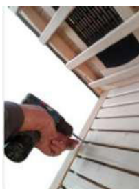
(9) Postavite klop in uporabite vijake 4x50 mm da pritrdite klop, kot je prikazano na spodnji sliki
