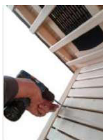
(9) Pripevnite lavicu (4x50mm)
