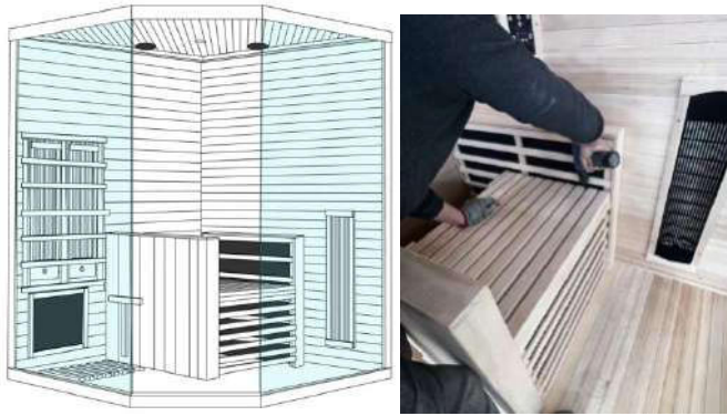
(9) Asamblați bancheta și utilizați 4 bucăți de șuruburi 4x50 pentru a fixa bancheta.
