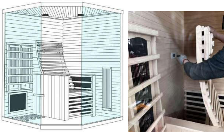
(10) Configurați spătarul scaunului și conectați alimentarea pentru încălzitorul spătarului.
